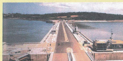
CENTRAL DE LA RANCE, FRANCIA. Ten 24 turbinas impulsadas por 1.000 toneladas de auga por segundo, cunha potencia de 240 MW.
