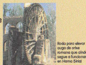
Roda para elevar auga de orixe romana que aínda segue a funcionar en Hama (Siria).
